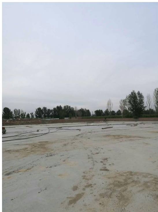
照片 2 东北侧-空地
